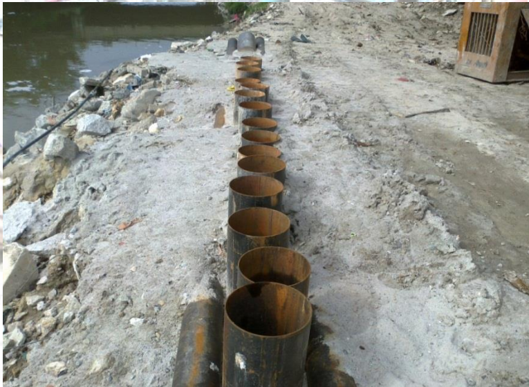
Project : Projek Tebatan Banjir Sungai Kerayong Dari Putfall Kolam Sri Johor Ke Taman Desa Sepanjang 2.0km Wialayah Persekutuan, Kuala Lumpur - Micropiling Works
