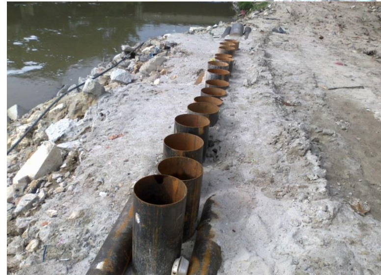
Project : Projek Tebatan Banjir Sungai Kerayong Dari Putfall Kolam Sri Johor Ke Taman Desa Sepanjang 2.0km Wialayah Persekutuan, Kuala Lumpur - Micropiling Works
