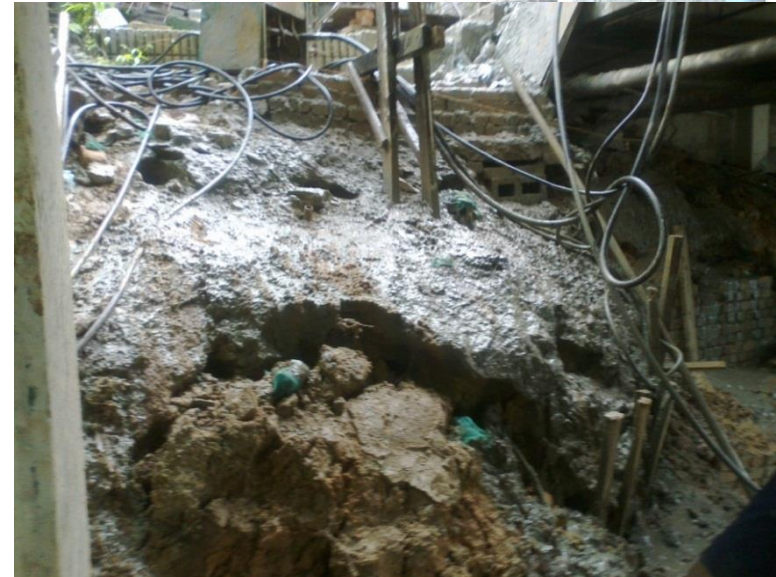
Project : Banglo 3 Tingkat Diatas Lot 3796, No. 48, Jalan Lingkungan Negeri Sembilan Federal Hill, Kuala Lumpur - Soil Nailing & Horizontal Drain
