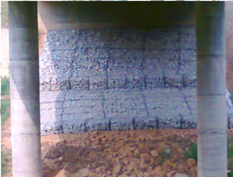
Project : Cadangan Membina, Menyiapkan Projek Kompleks Akademi Badan Pencegah Rasuh (MACA) Di Persiaran Duta, Mukim Batu, Daerah Kuala Lumpur Untuk Tetuan Jabatan Perdana Menteri Badan Pencegah Rasuh - Gabion Wall Works
