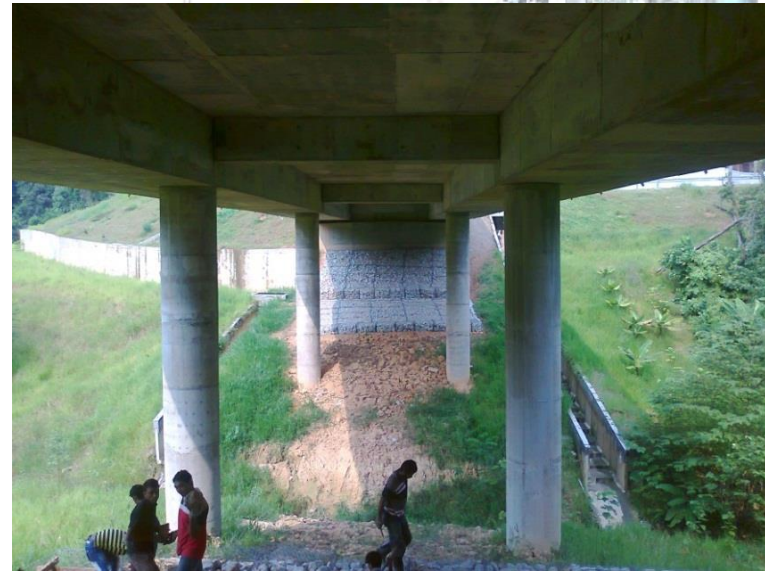
Project : Cadangan Membina, Menyiapkan Projek Kompleks Akademi Badan Pencegah Rasuh (MACA) Di Persiaran Duta, Mukim Batu, Daerah Kuala Lumpur Untuk Tetuan Jabatan Perdana Menteri Badan Pencegah Rasuh - Gabion Wall Works
