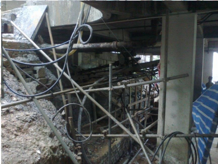
Project : Banglo 3 Tingkat Diatas Lot 3796, No. 48, Jalan Lingkungan Negeri Sembilan Federal Hill, Kuala Lumpur - Soil Nailing & Horizontal Drain
