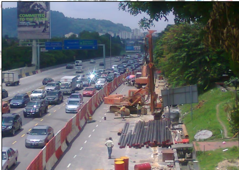
Project : Project Penyuraina Lalulintas Di Persimpangan Bertingkat Pandan Indah, MRR II, Kuala Lumpur - Micropiling Works
